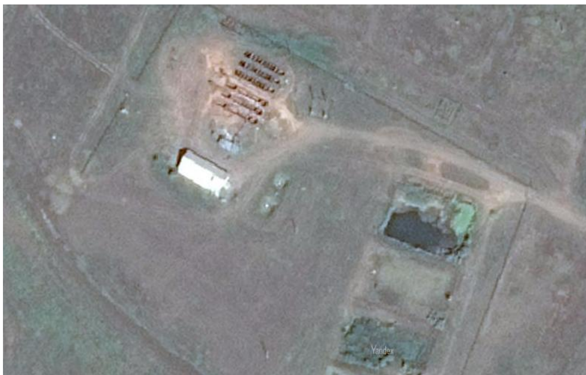
Рис.13 Биологические очистные сооружения пгт.Аксубаево
